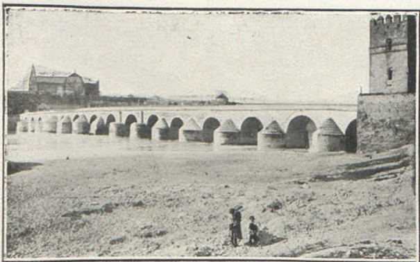
El Puente Romano.
